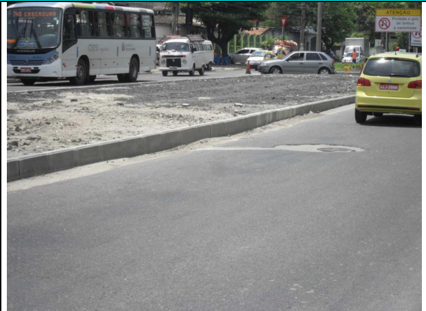
Figuras 11 e 12 – Concretagem para fixação de meio fio na Estrada de Jacarepaguá (interseção próxima à AMBEV).
