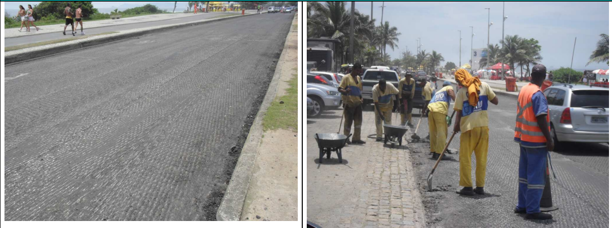
Figuras 15 e 16 – Avenida Lúcia Costa (altura do nº 2916 – Pista da Praia): serviços de fresagem e limpeza de bordos em execução
