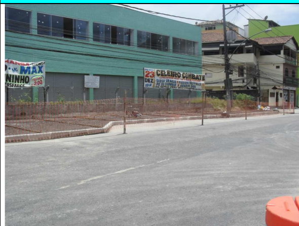
Figura 13 – Localidade do Tijuquinha: realização de alargamento da pista, construção de baias de ônibus e execução de serviços de fresagem e recapeamento.
