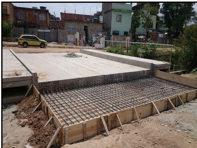
Foto 13 – Lançamento tabuleiro da ponte, atualmente realizando-se a estrutura de encontro da ponte com a futura via a ser pavimentada.
