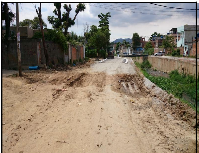
Foto 15 – Início da pavimentação da Avenida do Canal.
