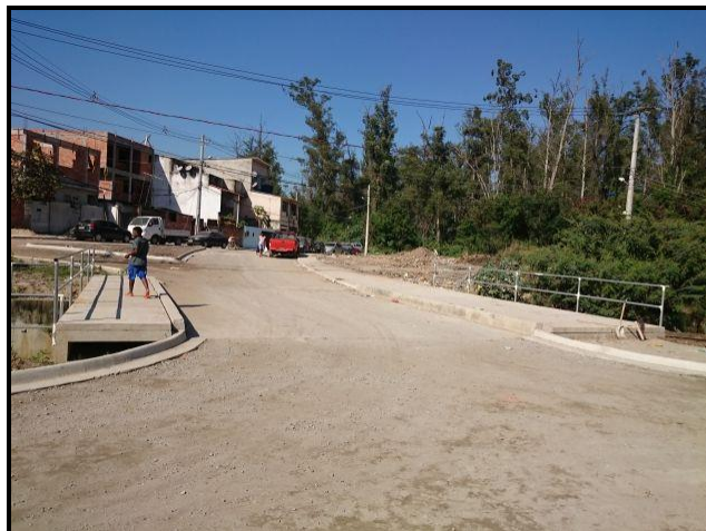
Foto 14 – Ponte "7" totalmente concluída.
