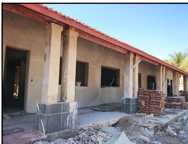
Foto 04 – Pavilhão teve avanço considerável: alvenaria divisória concluída, lajes concluídas, telhado concluído, fachada rebocada, instalações concluídas. Falta instalação de esquadrias, de bancadas, revestimentos internos, piso interno, etc.
