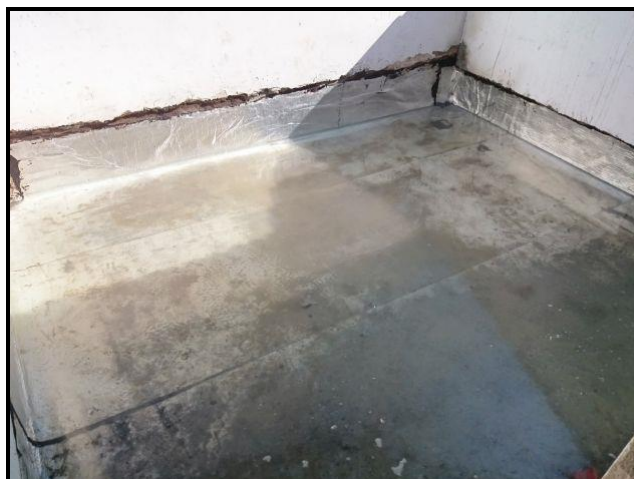
Foto 25 – Impermeabilização da varanda do pavilhão rosa com manta asfáltica.
