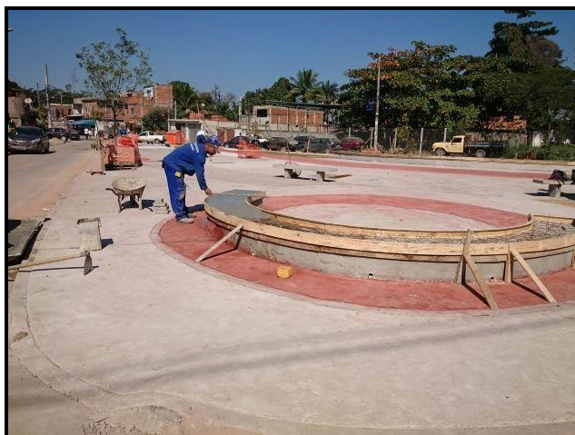
Foto 02 – Praça 11 em processo de conclusão.
