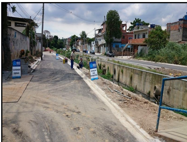
Foto 17 – Colocação de guarda corpo ao longo da Rua do Canal (córrego do engenho novo).
