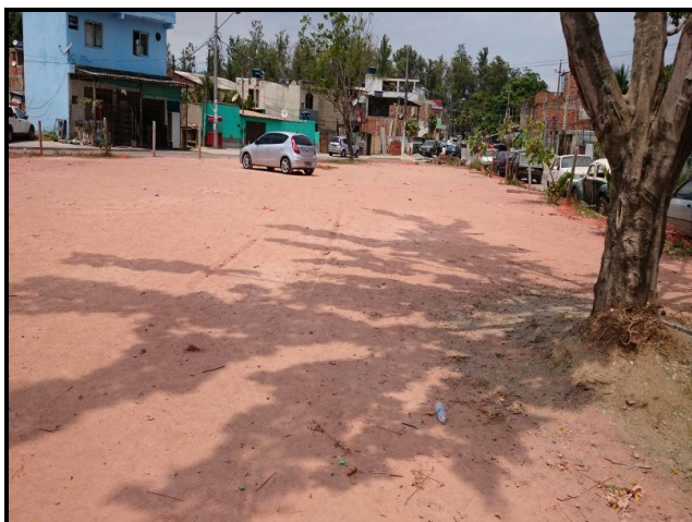
Foto 01 – Praça 11 recebeu tratamento de solo e regularização do terreno.
