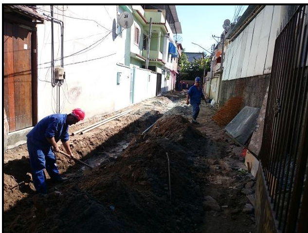
Foto 19 – Beco na estrada do Guerengê 2114-A iniciando execução.
