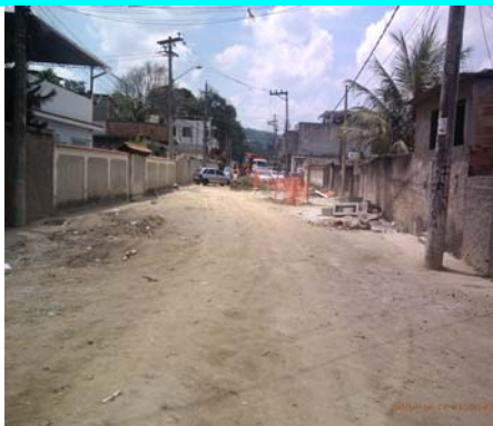
Figura 23 – Rua Nossa Senhora de Fátima restando a pavimentação.
