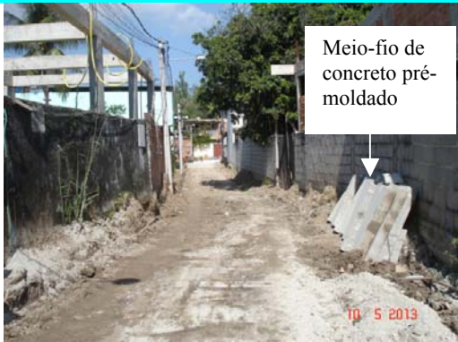
Figura 29 – Rua Sampaio Correa, 110: pavimentação a executar.
