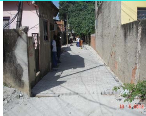
Figura 28 – Rua Sampaio Correa, 134: pavimentação em execução.
