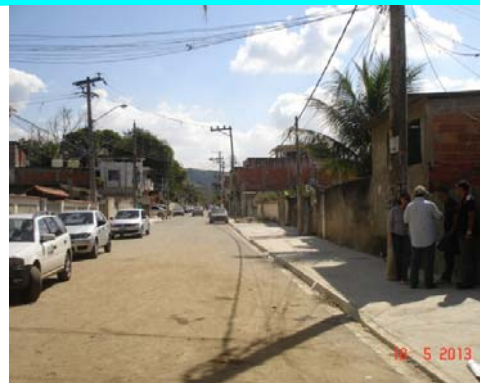
Figura 24 – R. Nossa Senhora de Fátima concluída.
