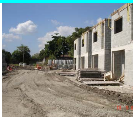
Figuras 10,11 e 12 - Três ângulos diferentes das casas em execução, em alvenaria.
