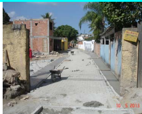
Figura 26 – Rua Sampaio Correa, 116: trecho em execução.
