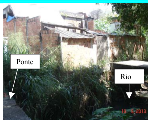
Figura 35 – Casa a ser demolida
