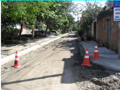
Figura 3 – Rua Onil Machado Gitahy com parte dos passeios e meio-fio executados.
