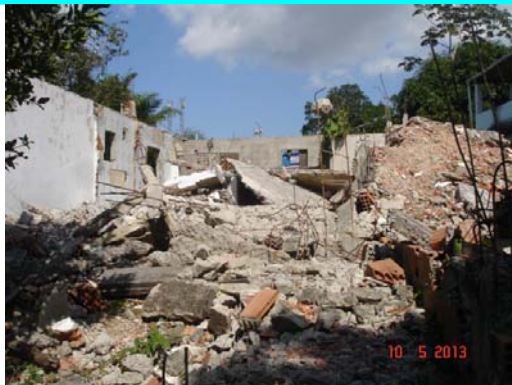
Figura 36 – Casa em demolição
