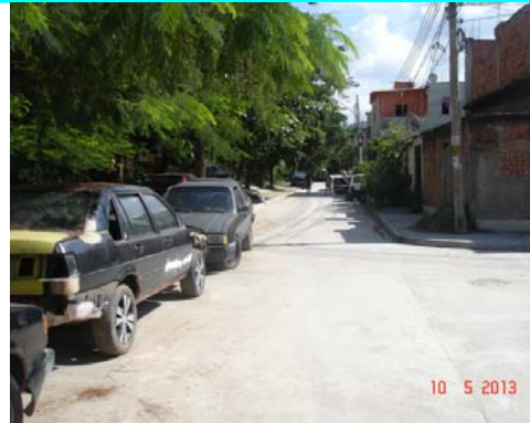
Figura 4 – Mesma rua, totalmente pavimentada.
