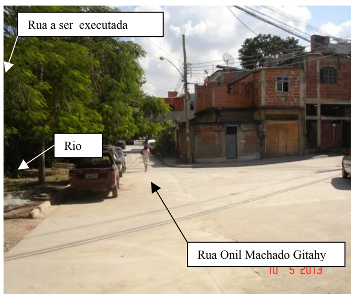
Figura 33 - Rua Onil Machado Gitahy
