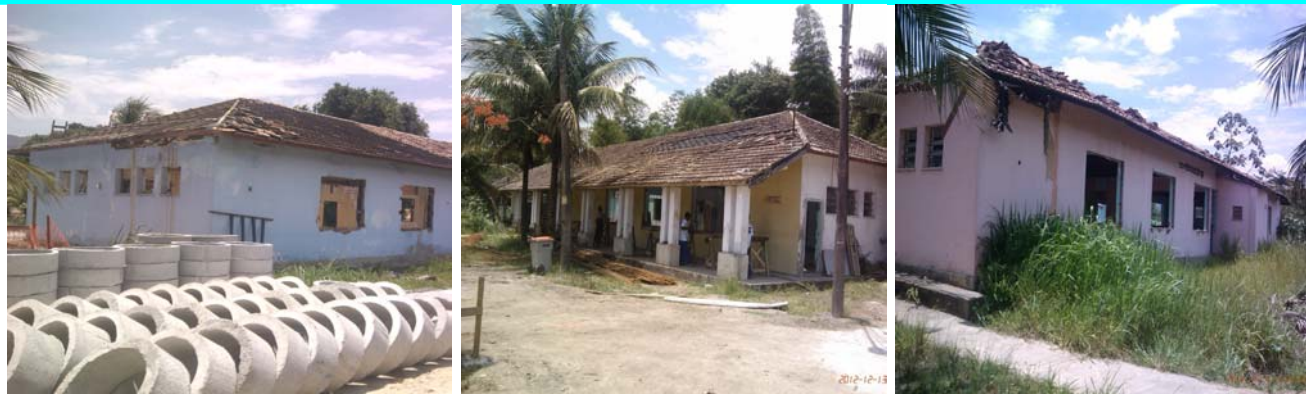
Figura 16, 17 e 18 – Antigos pavilhões da Colônia em reforma.
