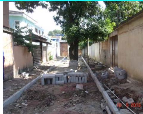
Figura 30 – Rua Sampaio Correa, 110 A em execução.
