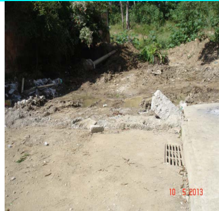
Figura 22 – Mesmo trecho, com pequena intervenção na pavimentação.
