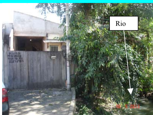
Figura 34 – Margem esquerda do rio, com casa a ser demolida. Rio à direita.
