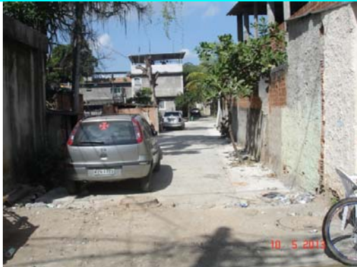
Figura 27 – Rua Sampaio Correa, 130F: finalizando a execução.
