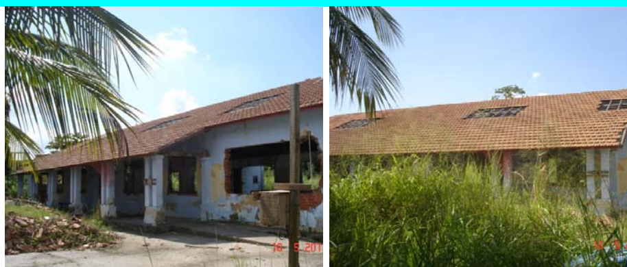
Figuras 19 e 20 – Somente os telhados dos Pavilhões sofreram intervenção.
