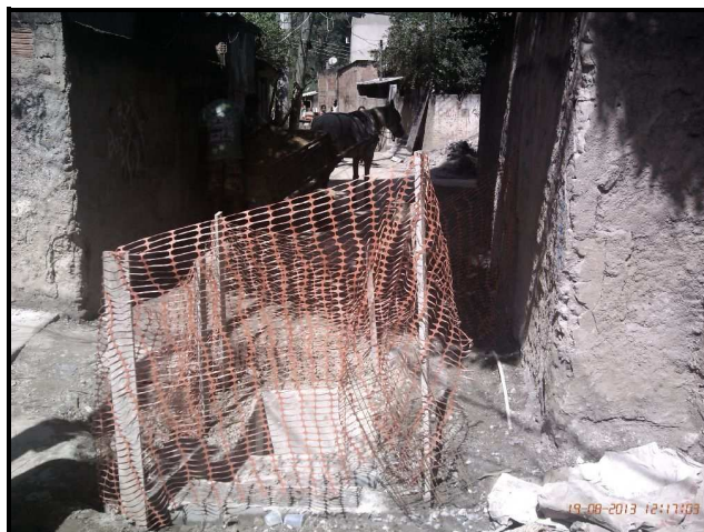
Foto 27 – Rua Verde B. Caixa de drenagem em execução.
