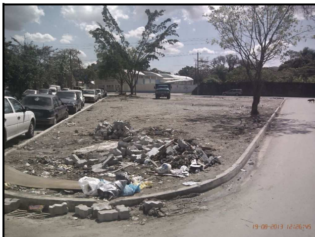
Foto 30 - Praça 11 - a executar.
