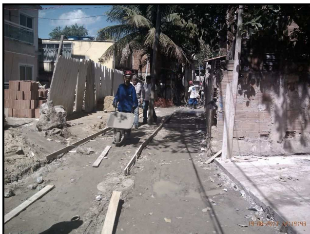
Foto 28 – Rua Verde 41 - em execução.
