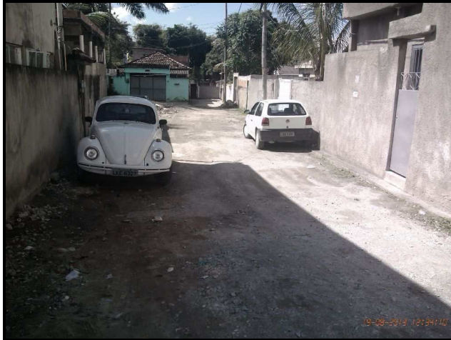
Foto 34 – Rua N. Sra. de Fátima 15 - a executar.
