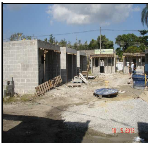
Figuras 01,02 e 03 - Três ângulos diferentes das casas em execução, em alvenaria.
