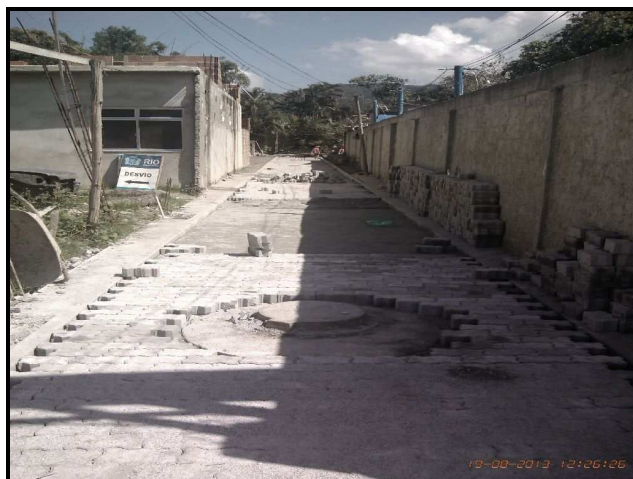
Foto 29 – Rua Projetada 34 - em execução.
