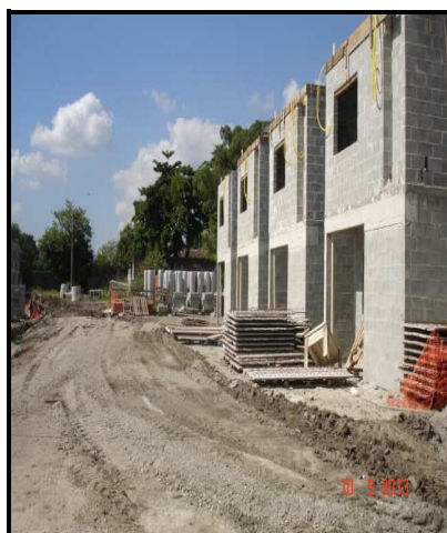
Figuras 01,02 e 03 - Três ângulos diferentes das casas em execução, em alvenaria.
