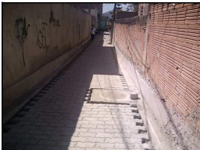
Foto 26 – Rua N. Sr.ª Fátima, 31 - em execução.
