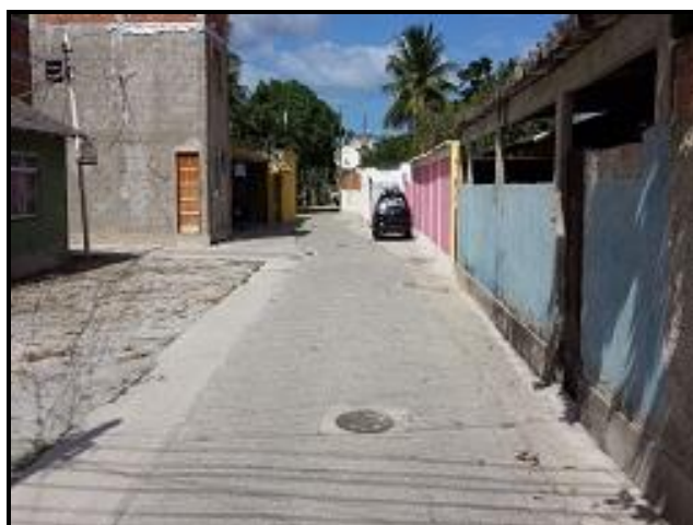
Figura 15 – Rua Sampaio Correa, 120. Concluída.
