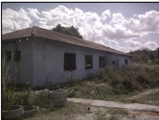
Figura 08 – Pavilhões em reforma.
