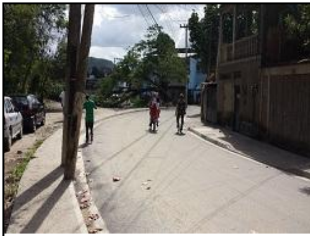
Foto 28 – Rua Verde C com aplicação de CBUQ (asfalto) concluído.
