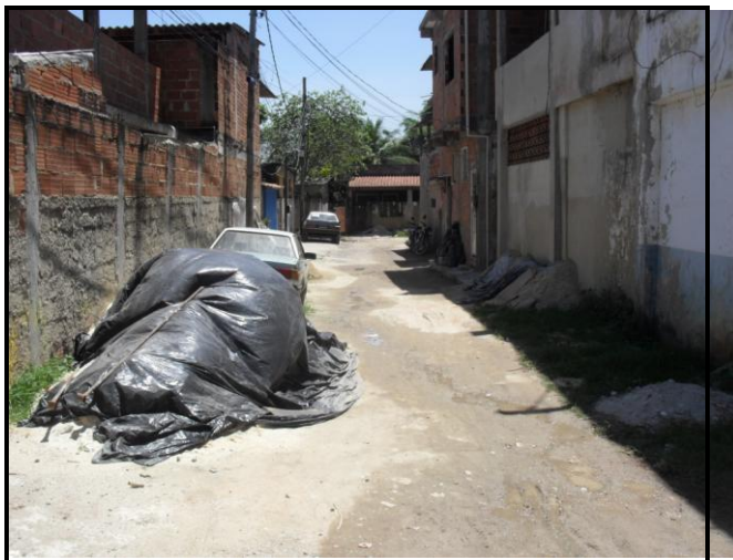
Foto 23 – Rua N. Sra. de Fátima 5 a executar.
