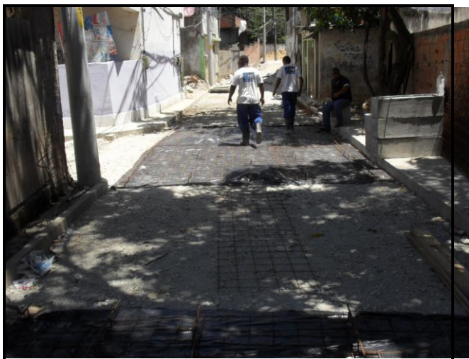
Foto 17 – Rua Verde 41. Pavimentação em concreto em execução.
