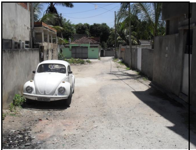
Foto 25 – Rua N. Sra. de Fátima 15 a executar.
