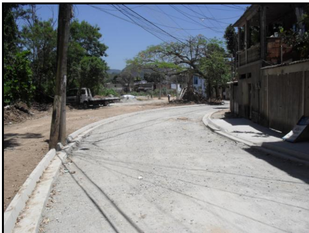
Foto 27 – Rua Verde C com base concluída aguardando a aplicação de CBUQ (asfalto).
