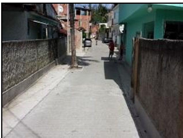
Figura 14 – Rua Sampaio Correa, 112. Concluída.
