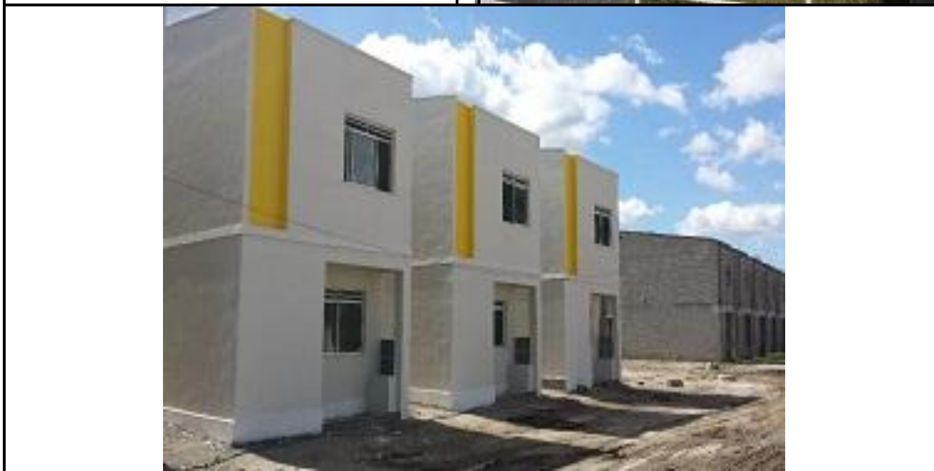
Figuras 05 a 07- Vista atualizada das casas em execução, em alvenaria.
