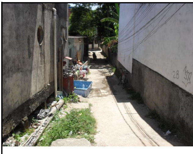
Figura 21 – Rua N. Sra. de Fátima 2 a executar.
