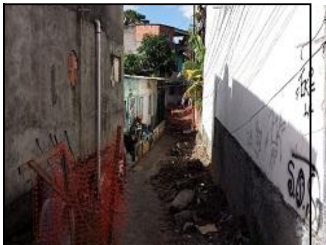
Figura 22 – Rua N. Sra. de Fátima 2 em execução.
