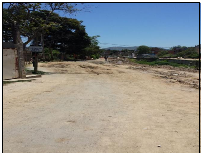
Foto 18 – Avenida do Canal a ser pavimentada.
