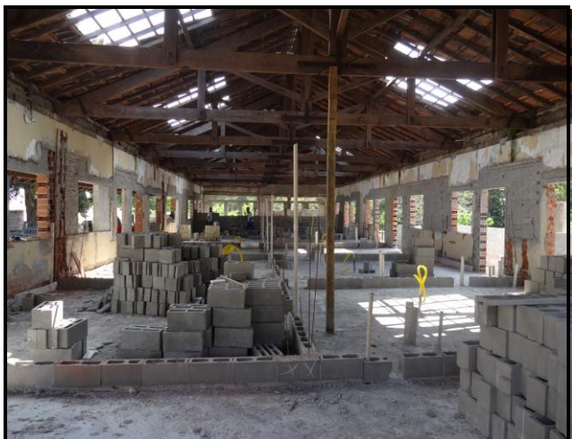
Foto 05 – Pavilhão amarelo iniciando a execução das paredes divisórias
