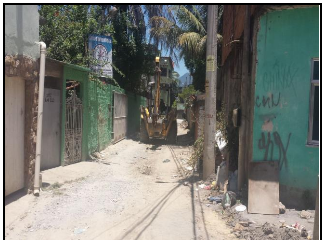
Foto 20 – Estada do Guerengê nº 21, beco 12 A, a ser pavimentado.
