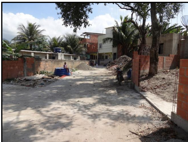
Foto 15 – Rua Nossa Senhora de Fátima 2 em execução
