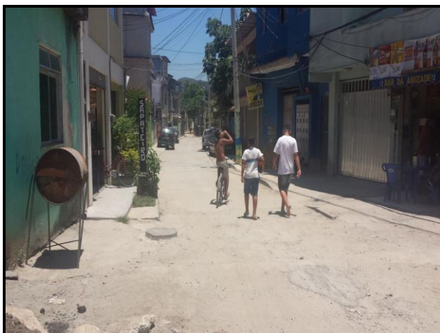
Foto 21 – Estrada do Guerengê nº 21, beco 12 B, a ser pavimentado.
