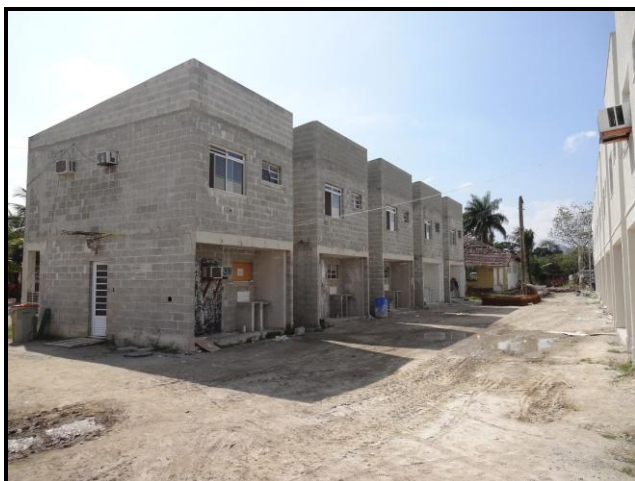
Foto 03 – Casas em execução.
