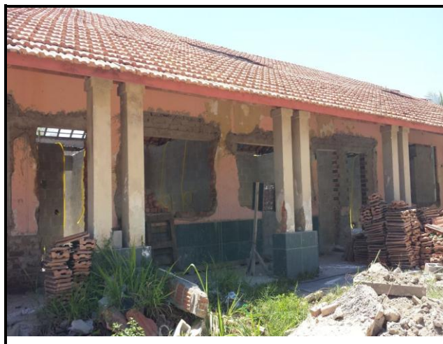
Foto 08 – Pavilhão com alvenaria divisória suspensa, iniciando os lançamentos das lajes pré-moldadas, instalações hidrosanitárias, telhas trocadas, reparos na alvenaria.
