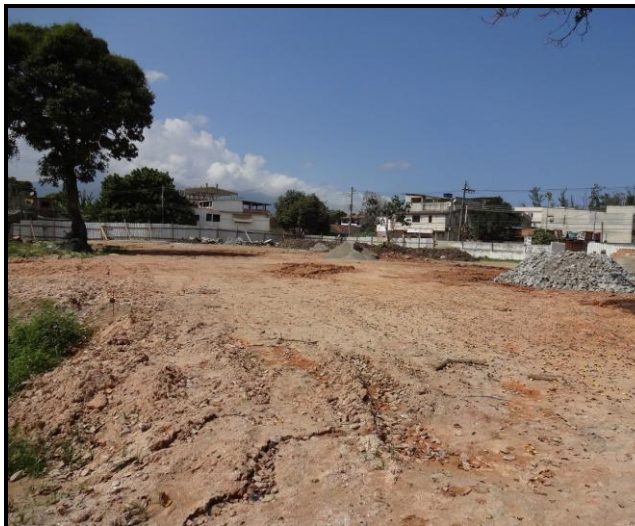
Foto 11 – Antiga estação de tratamento de esgoto e futuro Centro Poliesportivo. Fase de preparação do terreno.
