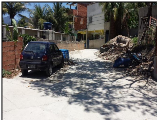
Foto 16 – Rua Nossa Senhora de Fátima concluída.
