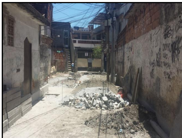
Foto 22 – Estrada do Guerengê nº 21, beco 16 A, sendo pavimentado.
