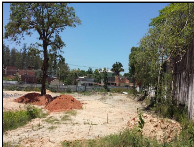
Foto 10 – Permanece pendente a execução das 12 casas.
