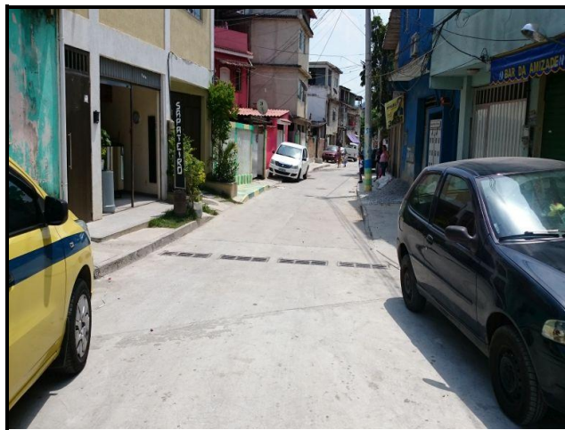
Foto 24 – Estrada do Guerengê nº 21, beco 12 B, pavimentação concluída, instalação de drenagem à mostra.
