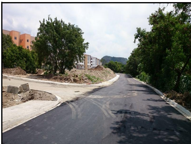
Foto 27 – Rua Projetada 10 com pavimentação praticamente concluída.
