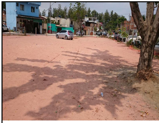
Foto 02 – Praça 11 recebeu tratamento de solo e regularização do terreno.
