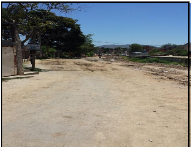
Foto 17 – Avenida do Canal a ser pavimentada.
