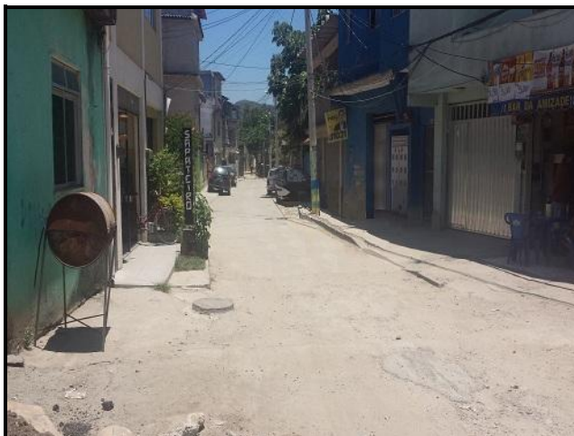
Foto 23 – Estrada do Guerengê nº 21, beco 12 B, a ser pavimentado.
