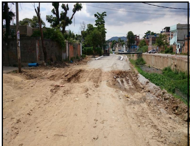
Foto 18 – Início da pavimentação da Avenida do Canal.
