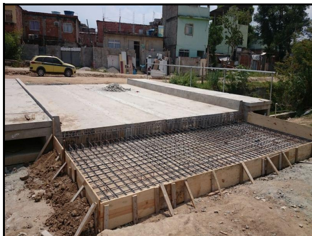
Foto 16 – Lançado tabuleiro da ponte, atualmente realizando-se a estrutura de encontro da ponte com a futura via a ser pavimentada.
