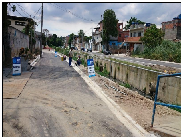
Foto 28 – Colocação de guarda corpo ao longo da Rua do Canal (córrego do engenho novo).
