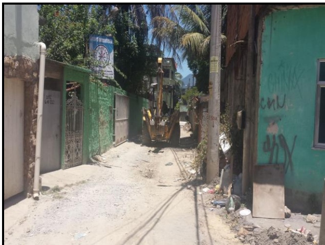
Foto 21 – Estrada do Guerengê nº 21, beco 12 A, a ser pavimentado.
