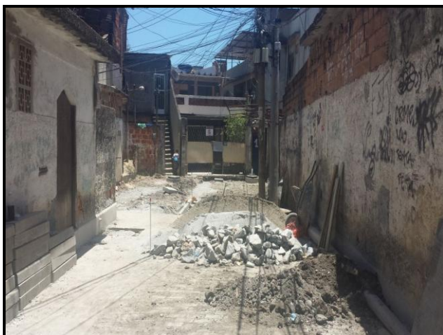
Foto 25 – Estrada do Guerengê nº 21, beco 16 A, iniciando pavimentação.
