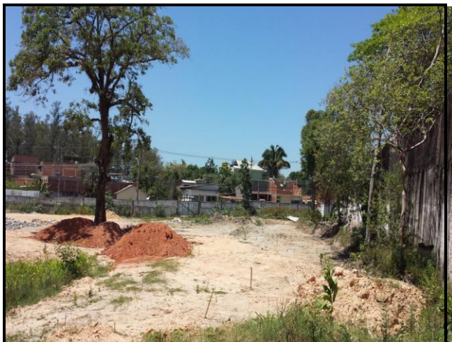
Foto 09 – Permanece pendente a execução das 12 casas.
