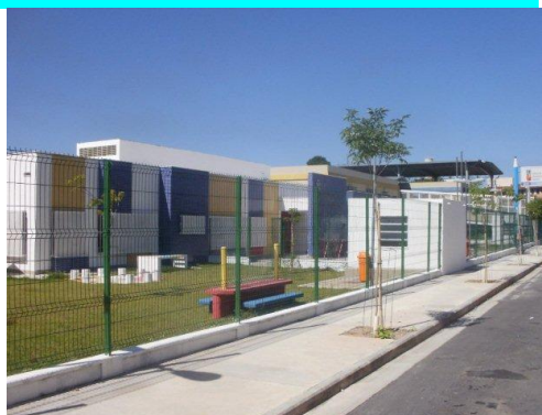
Figura 22 – Obra completamente finalizada.
