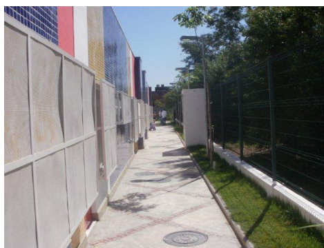
Figura 20 – Janelas já protegidas com grades.
