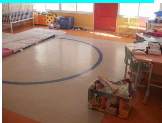
Figura 30 – Piso vinílico aplicado nas salas de atividades
