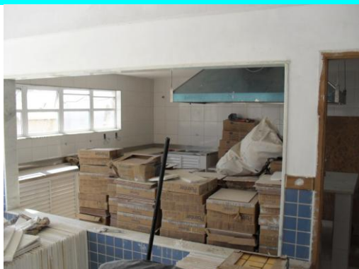
Figura 27 – A cozinha foi finalizada aguardando mobiliário.
