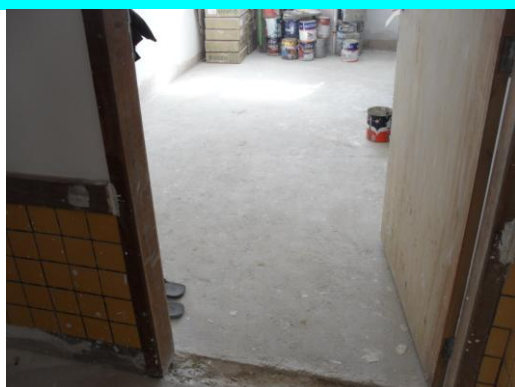
Figura 29 – Aplicação de piso vinílico nas salas de atividades
