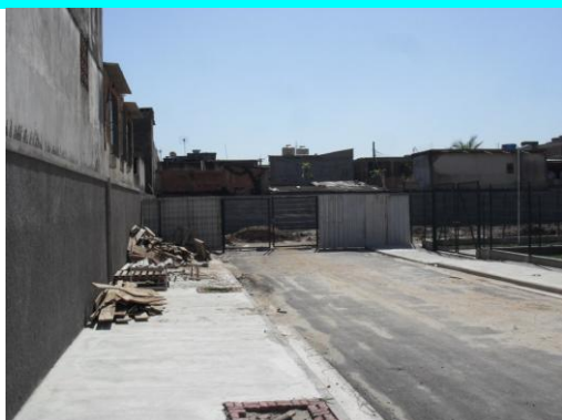
Figura 23 – Visão atual da via de acesso com meio fio.
