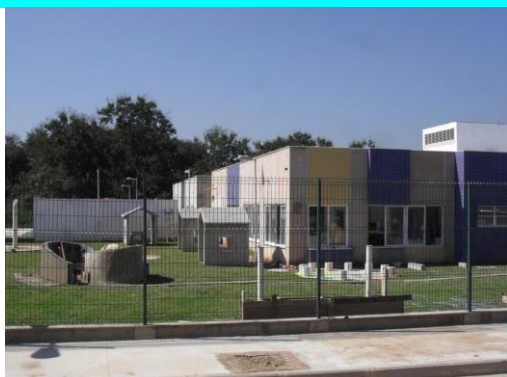
Figura 21 – Vista geral da EDI, mostrando a cobertura, e compartimento das caixas d'água.
