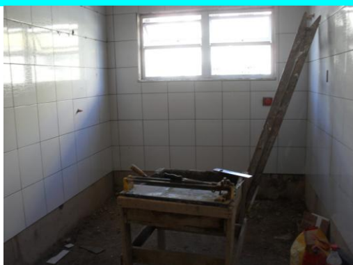
Figura 25 – Os banheiros estão em fase de acabamento.
