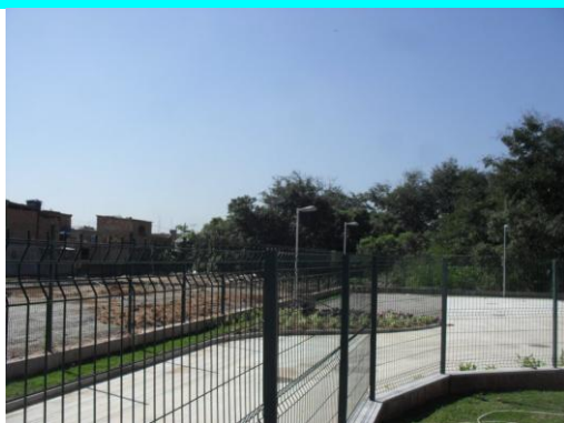
Figura 1 – Visão atualizada dos fundos da EDI (área limítrofe a comunidade)
