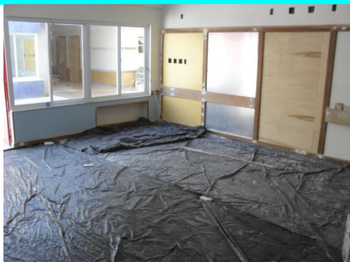
Figura 13 – Vista atual das salas de atividade 07 e 08
