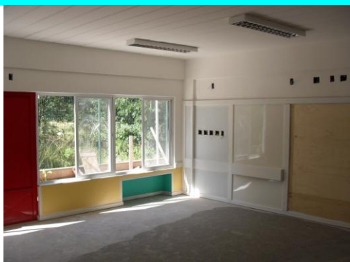
Figura 11 – Vista atual das salas de atividade 05 e 06
