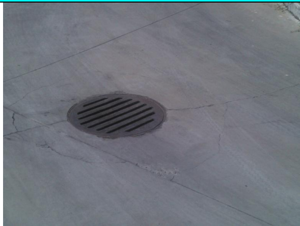
Figuras 13 e 14 – Afundamento do piso em volta do tampão de ferro
