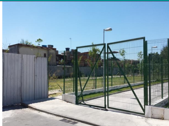
Figura 11 - Portão do estacionamento com problemas para fechar.
