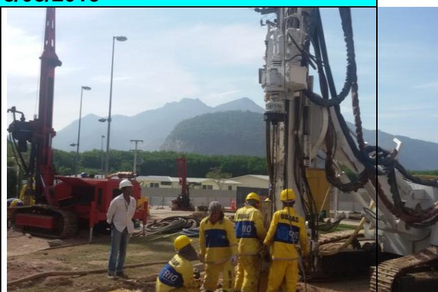
Figura 06 - Cravação de estacas.
