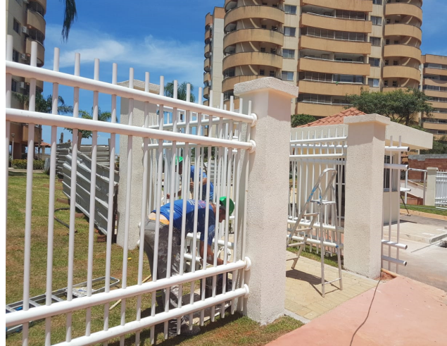
Fotos 5 – Reparos em execução.
