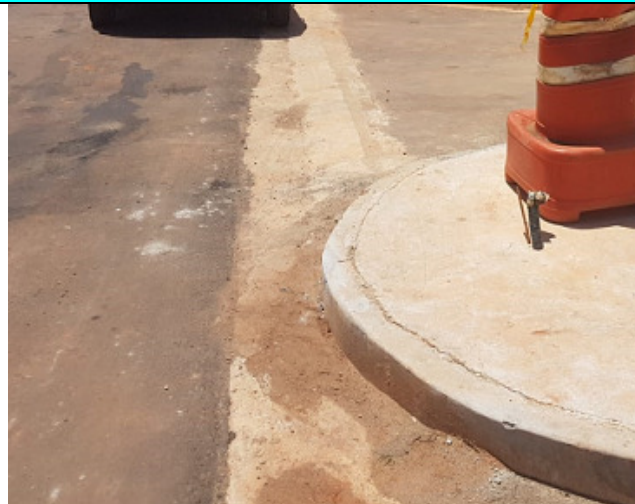
Fotos 7 – Reparos em execução.
