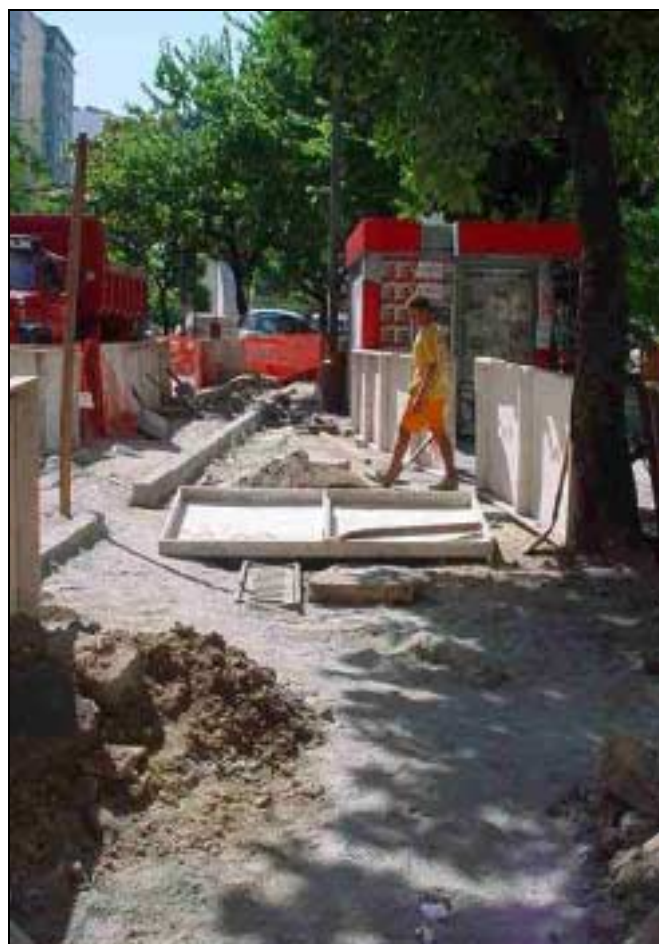
Figura 7 – Novo alinhamento do meio-fio no final do trecho sob intervenção (junto à rua São Salvador).
