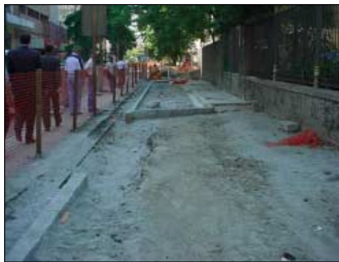
Figura 6 - Trecho com novo alinhamento da calçada.
