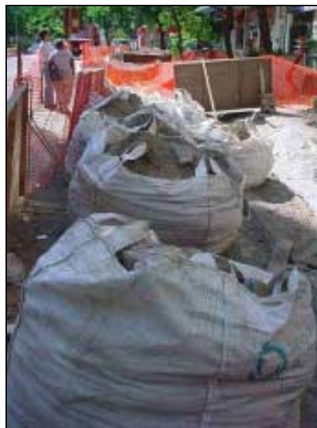
Figura 2 - Demolição - Utilização de sacos para agilizar a remoção do material.
