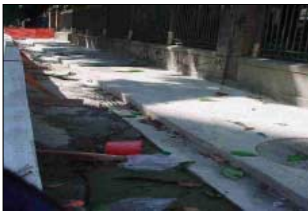
Figura 5 - Novo calçamento em concreto.
