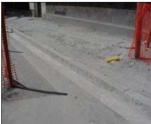
Figura 3 - Meio-fio e sarjeta já instalados.
