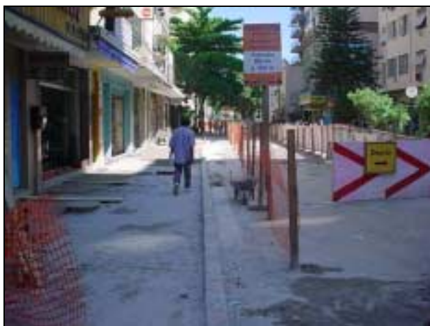
Figura 4 - Sinalização e proteção ao longo do trecho sob intervenção.
