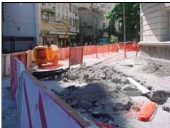
Figura 1 – Início da Intervenção no trecho junto à Praia de Botafogo. Aguardando ligação da CEDAE.
