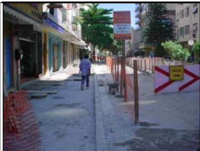
Figura 5 – Execução de calçamento registrado na visita anterior (lado ímpar).
