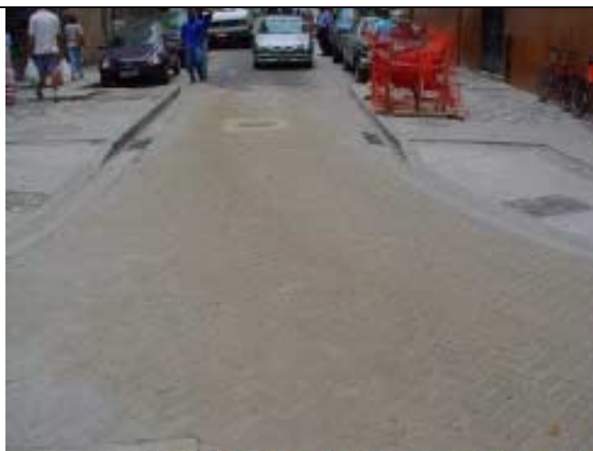
Figura10 -Embocadura pavimentada com piso intertravado amarelo, na rua Fernando Osório com a rua Marques de Abrantes concluída
