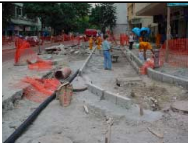
Figura14 -Início da intervenção no lado par da rua Marques de Abrantes a partir da Rua São Salvador.
