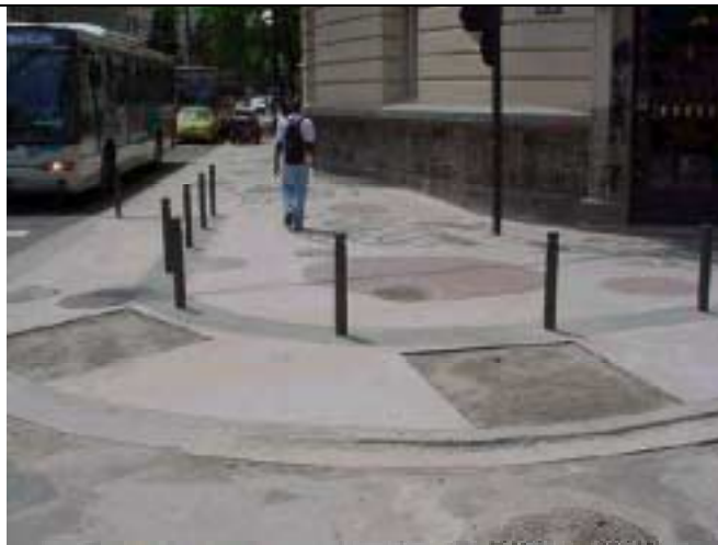
Figura 2 – Mesmo trecho com o calçamento concluído e preparado para receber o novo posteamento.
