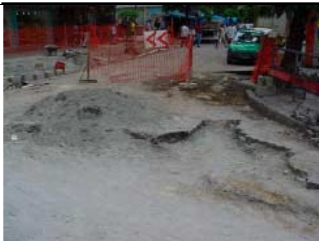
Figura13 -Embocadura em execução na rua São Salvador com rua Marques de Abrantes.
