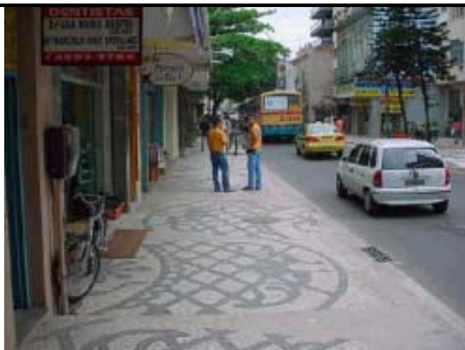
Figura 6 – No mesmo local, calçamento e captação de drenagem concluídos.
