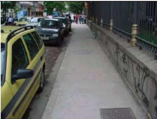
Figura 4 – No mesmo local, alinhamento executado com baia para estacionamento.
