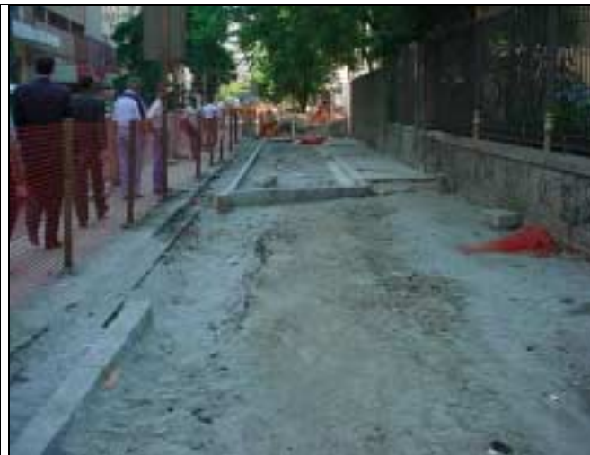
Figura 3 – Execução de novo alinhamento da calçada registrado na visita anterior.
