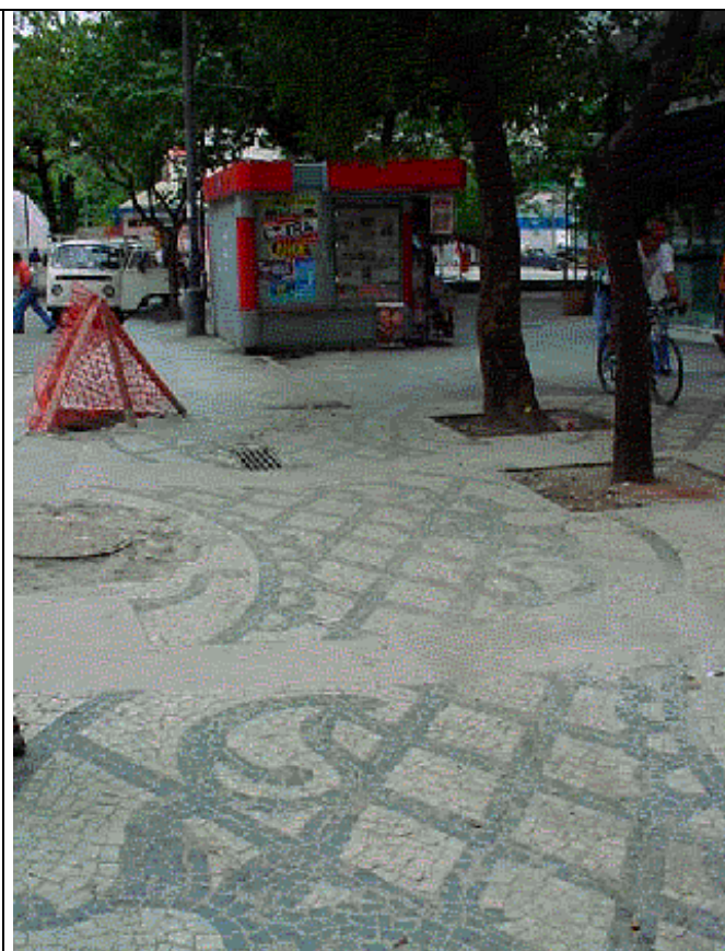
Figura 8 – Mesmo local, execução quase finalizada.
