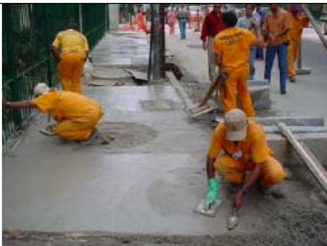
Figura16 -Passeio em execução na altura do nº126 da rua Marques de Abrantes.
