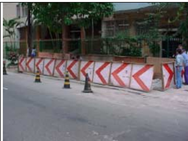
Figura9 -Intervenções realizadas pela Companhia Estadual de Gás e Telemar provocam atraso no andamento da obra.
