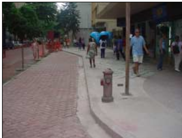
Figura 15 - 3ª Visita 12/2003 - Trecho Concluído.
