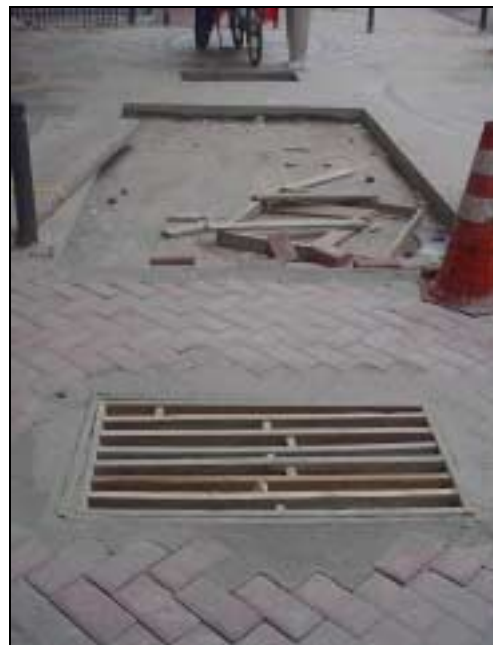
Figura 21 - Detalhe de caixas da LIGHT pendentes de serem niveladas. Rua Marques de Abrantes (lado par) prox. ao Banco Itaú.
