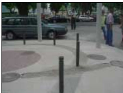
Figura 4 - 3ª Visita 12/2003 - Detalhe do corte no piso entre as caixas da CET-Rio - Pendência da obra.
