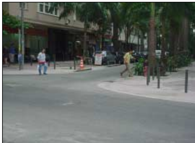
Figura 11 - 3ª Visita 12/2003 – Pendente a execução da pavimentação asfáltica
