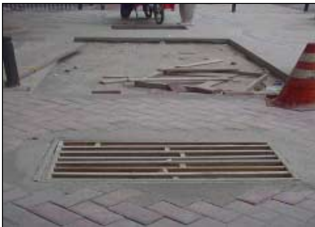
Figura 21 -3ª Visita 12/2003 Detalhe de caixas da LIGHT pendentes de serem niveladas.
