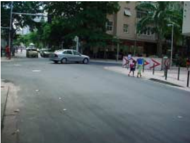
Figura 9 - 4ª Visita 03/2004- Execução da pavimentação asfáltica.
