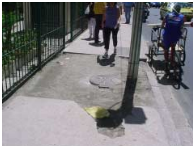
Figura 18 - 4ª Visita 03/2004 –Calçada que será refeita(Check-List) devido a instalação de poste.
