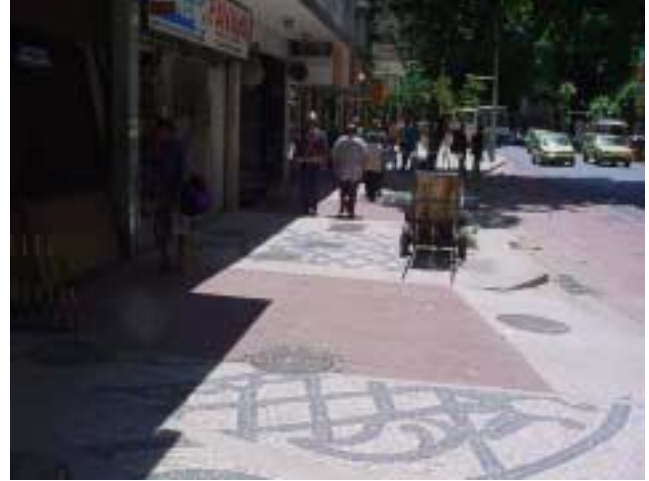
Figura 24 -4ª Visita 03/2004 - Passeios e entrada de garagem acabados.
