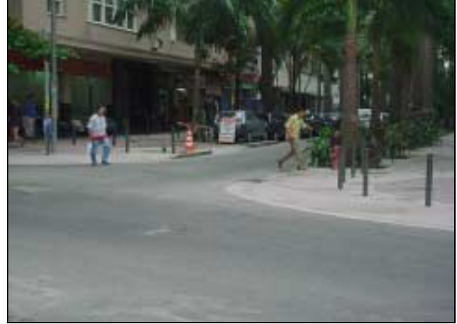
Figura 8 - 3ª Visita 12/2003 – Pendente a execução da pavimentação asfáltica.
