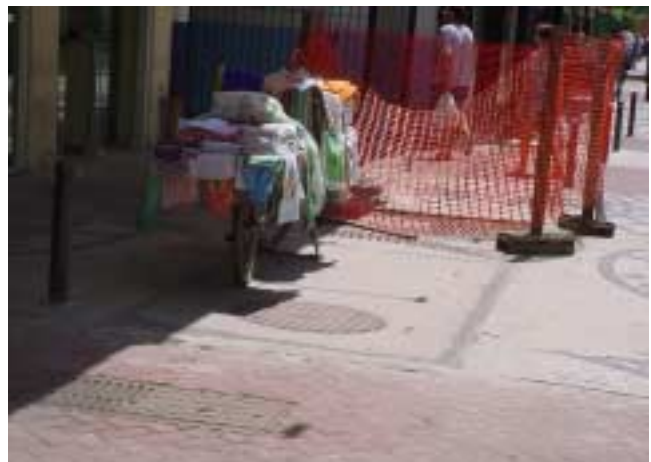
Figura 22 -4ª Visita 03/2004 Detalhe de caixas da LIGHT niveladas.
