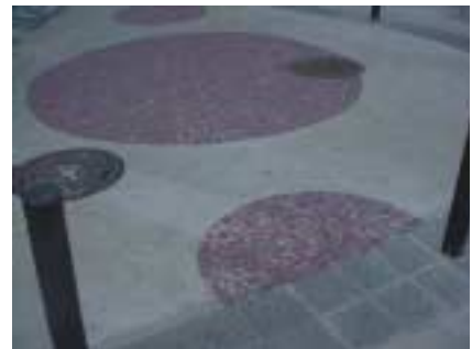
Figura 6 - 4ª Visita 03/2004 - Detalhe do corte no piso entre as caixas da CET-Rio. Trecho que será refeito (Check-List).
