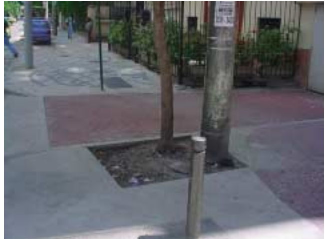
Figura 20 - 4ª Visita 03/2004 -Detalhe de passeio acabado.
