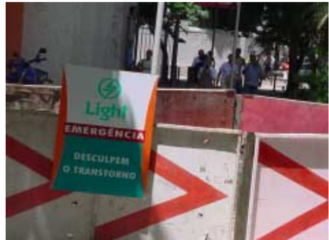
Figura 10 - 4ª Visita 03/2004 – Nivelamento de caixa de energia da rede de iluminação pública e da sinalização semafórica.
