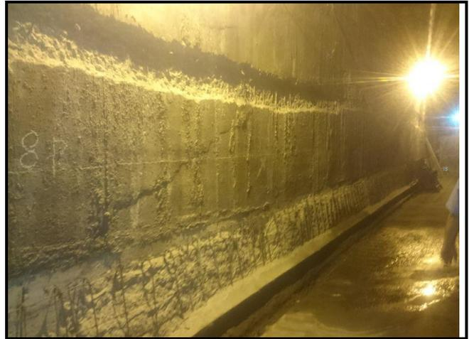
**Foto 10** – Observou-se que, em linhas gerais, o apicoamento do concreto das paredes foi executado segundo uma faixa de largura fixa, a uma altura média do piso, conforme exibe foto.
