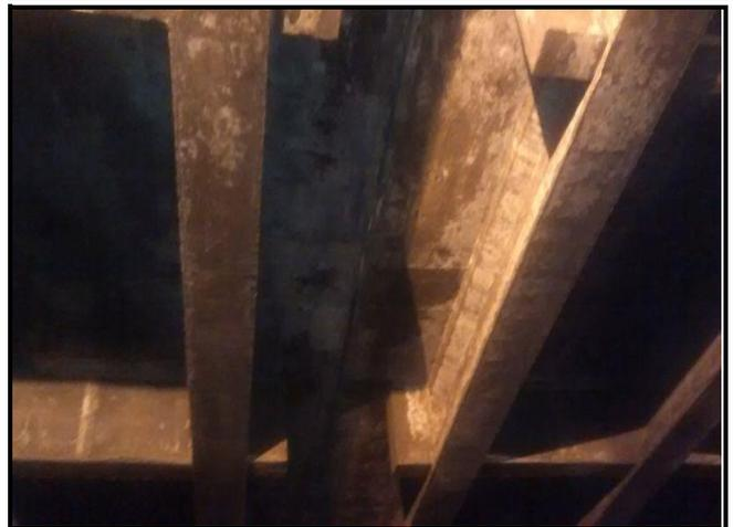
**Foto 08** – Uma das juntas de dilatação que deverá receber tratamento para evitar infiltração do nível superior.
