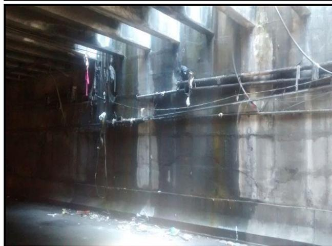
**Foto 04** – Foto adicional mostrando condição precária das instalações elétricas.
