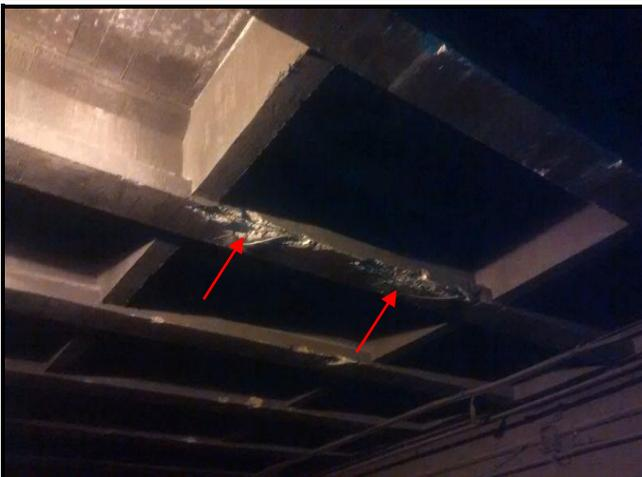
**Foto 07** – Avarias pontuais no vigamento da pista superior do túnel. Fora esses defeitos localizados, ocorridos provavelmente por choque de veículos altos, considera-se boa a situação dos vigamentos.
