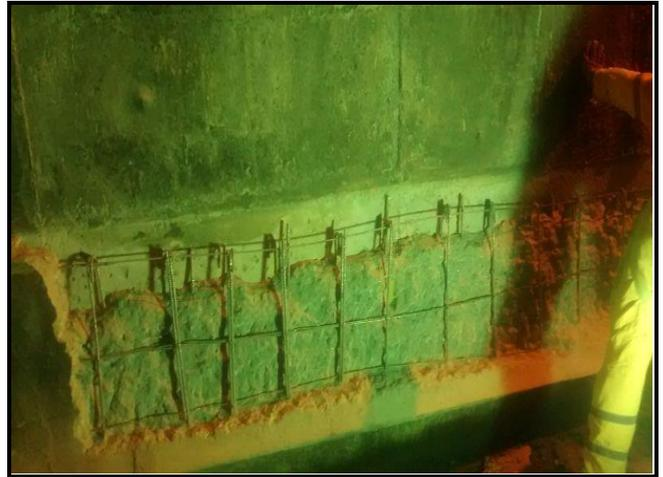
**Foto 06** – Apicoamento do concreto do guarda-rodas para recuperação da ferragem.
