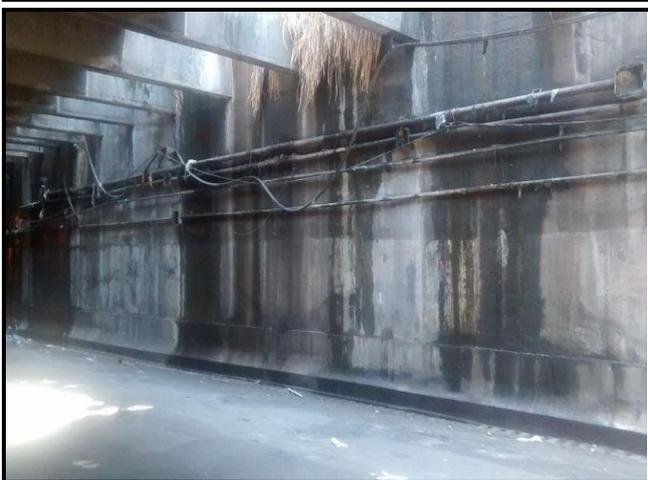
**Foto 03** – Instalações elétricas em estágio extremamente precário.
