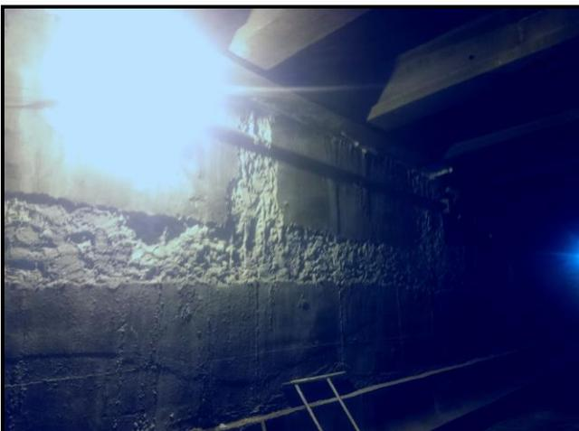
**Foto 11** – Aberturas na parede sendo fechadas novamente com argamassa.
