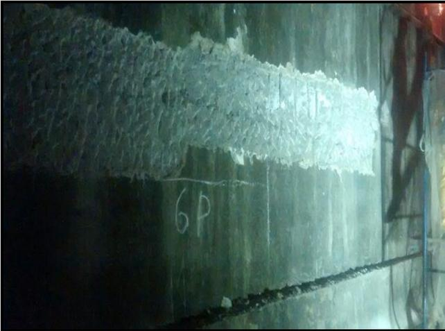
**Foto 05** – Apicoamento de concreto em trechos da parede lateral do túnel, para recuperação da ferragem.
