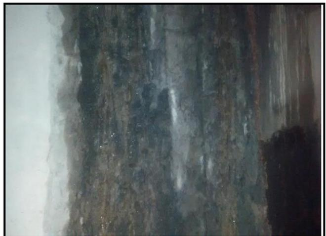
**Foto 12** – Ponto do túnel com grande infiltração, mesmo em dia seco.
