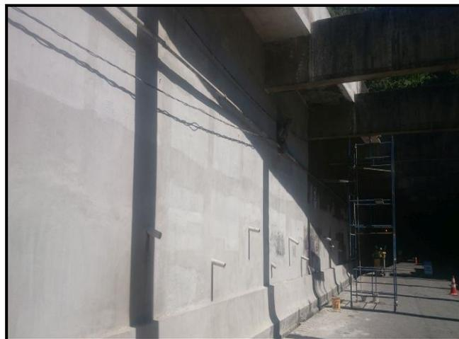
**Foto 02** – Pequeno trecho na entrada cuja parede esquerda encontrava-se concluída, com as devidas recuperações de ferrugem e com pintura final.
