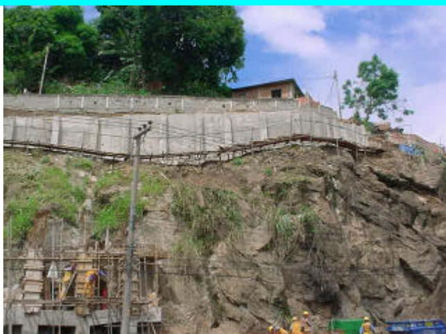
Figura 13 – Muro de concreto armado em execução próximo ao poste 7777/119.
