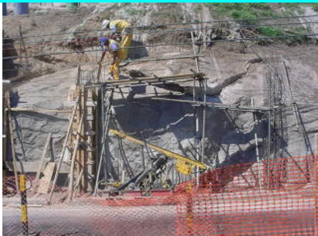
Figura 5 – Contrafortes em execução.
