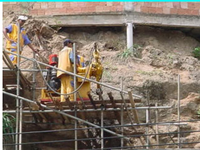
Figura 16– Perfuração para ancoragem do muro (cortina atirantada) próxima ao poste 7777/119.
