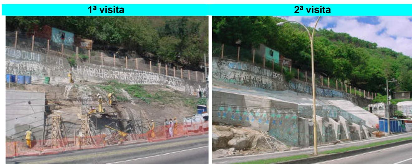
Figura 1 – Visão geral: à esquerda, parte da cortina ancorada; ao centro, contrafortes em execução; à direita, talude a ser revestido.
