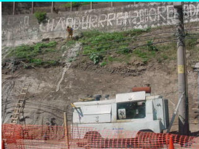
Figura 3 – Trecho do talude a ser revestido em concreto projetado.
