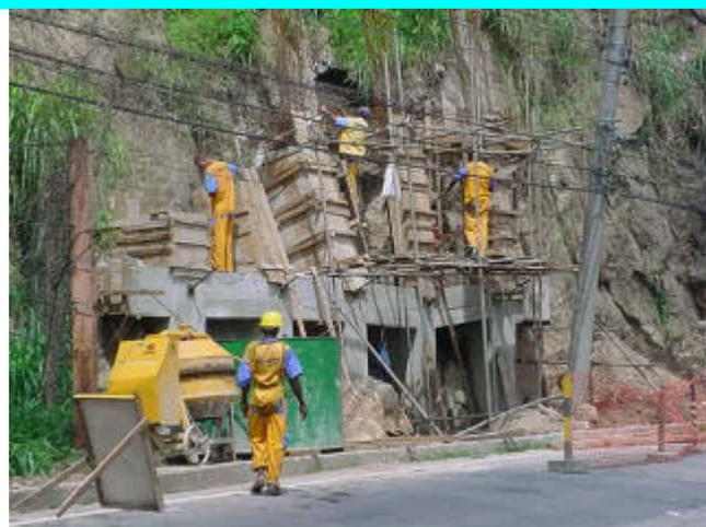
Figura 14– Contraforte em execução próximo ao poste 7777/119.
